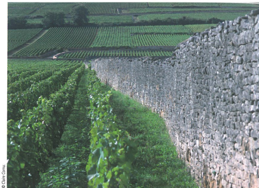
Photo 2: Mur en pierre sèche entre Chalonsur Saône et Buxy.
